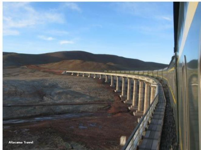
Lunghi tratti della colossale opera sono adagiati su permafrost, ovvero ghiacciai permanenti, con temperature di decine di gradi sottozero. Sono stati scavati 7 trafori (tra cui il Tunnel Fenghuoshan, la galleria posta alla maggiore altezza al mondo, un tunnel di 1.338 metri a 4.905 metri di altezza) e ben 286 ponti per consentire l'attraversamento delle brulle, ostili e incontaminate montagne tibetane.
